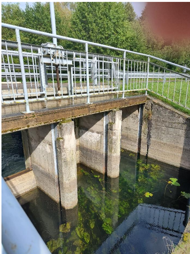
2 pav. Vandens pertekliaus pralaida su vandens nuleidimo uždoriu (viduryje) prie patvenkto Dusios ežero (a) ir šachtinė pralaida Kalesninkų tvenkinyje (b)
